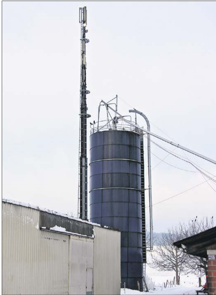
Eine Mobilfunkantenne wird in der Regel von einer Telefongesellschaft erstellt, andere mieten sich ein und jede zahlt an den Bauer. (Bild Hans Rüssli)
